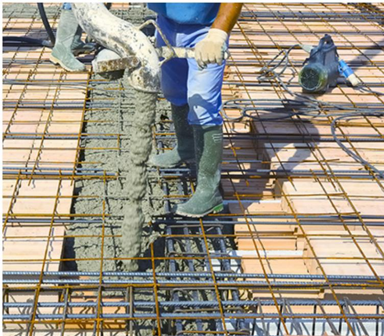
Para construir un edificio comercial de tal altura se requiere el mejor superplastificante disponible, ya que todo el concreto necesita ser bombeado, hasta el nivel 80, a unos 259 metros sobre nivel de terreno. El concreto también tuvo que cumplir con un rango de revenimiento de 160 mm a 200 mm para los diferentes niveles debido a la interacción de las barras de refuerzo.
