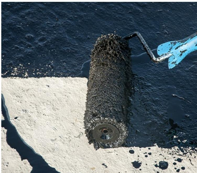
La construcción se centra cerca de la costa donde la capa freática es alta, lo cual requiere el uso de un sistema de impermeabilización avanzado, especialmente bajo nivel del suelo. El sótano estaba destinado a espacios "dedicados" en los que un ambiente seco y saludable era esencial: salas médicas, spa, piscina, cocinas, cafetería, sala de impresión y sala de reuniones que requerían una solución de barrera de vapor de alto rendimiento.
