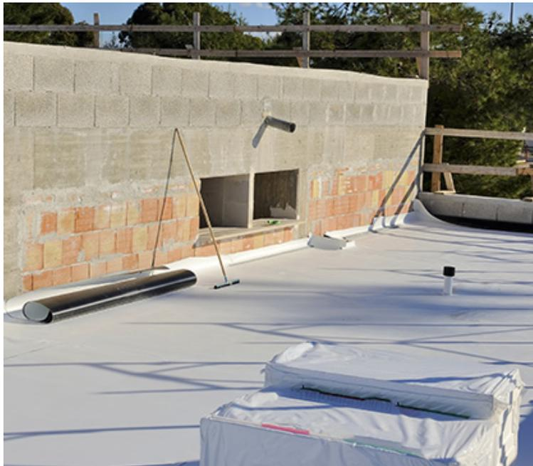
La construcción del estadio se centró en una zona donde el nivel de la capa freática era alto, lo que implicaba una cuidadosa planificación y organización del sitio. El agua con un grado de dureza altamente variable (y que, además, contiene sales y otros productos químicos particularmente agresivos) puede entrar en contacto con la construcción del estadio; esto requiere el uso de un sistema de impermeabilización avanzado.
